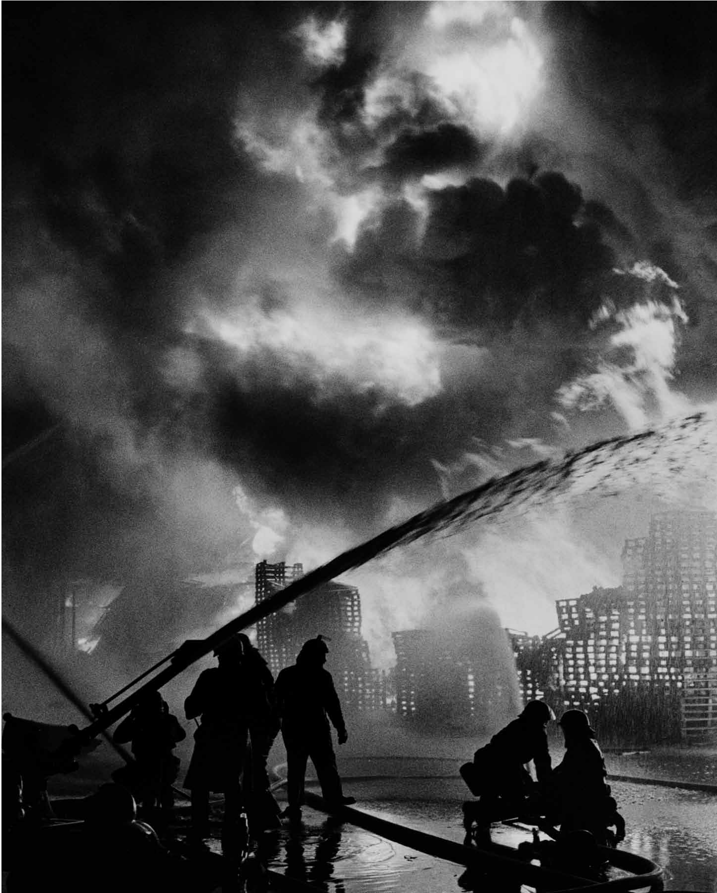
In der Brandnacht standen 260 Feuerwehrleute auf dem Werksgelände von Sandoz in Schweizerhalle im Einsatz.
