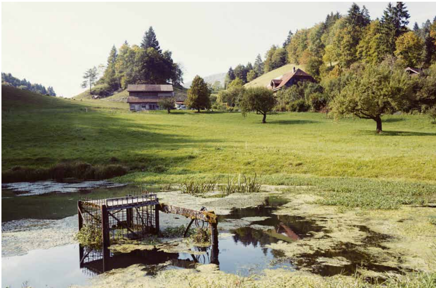
Der Longo-mai-Hof Montois liegt ausserhalb des jurassischen Dorfes Undervelier – unmittelbar oberhalb des Teiches, dessen Wasser die eigene Kraftwerksturbine antreibt.
