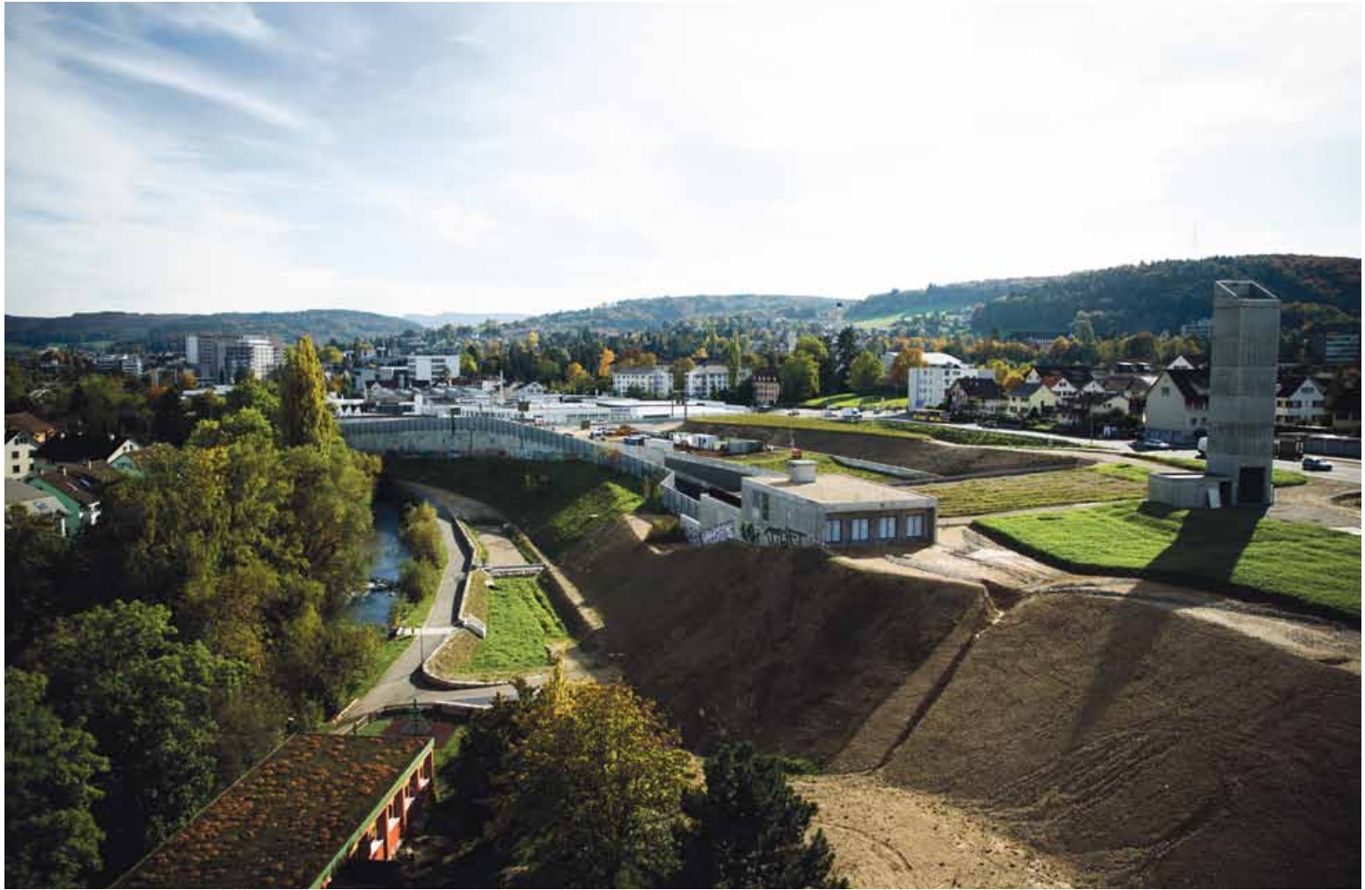
«Etwas gross jedenfalls»: der Tunnel als Herzstück der neuen H2 von Liestal nach Pratteln.
