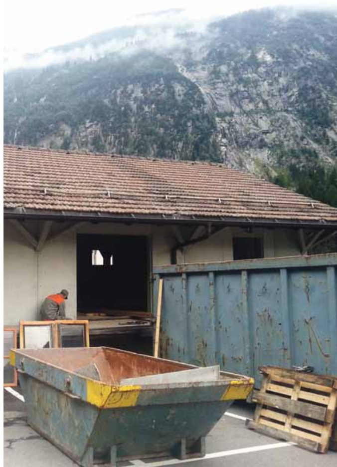
Dieser Einsatz gefährdet Ihre Gesundheit: Basler Zivilschützer bei der Arbeit. Im Vordergrund steht die Mulde mit den asbesthaltigen Eternitplatten. Foto: zVg
