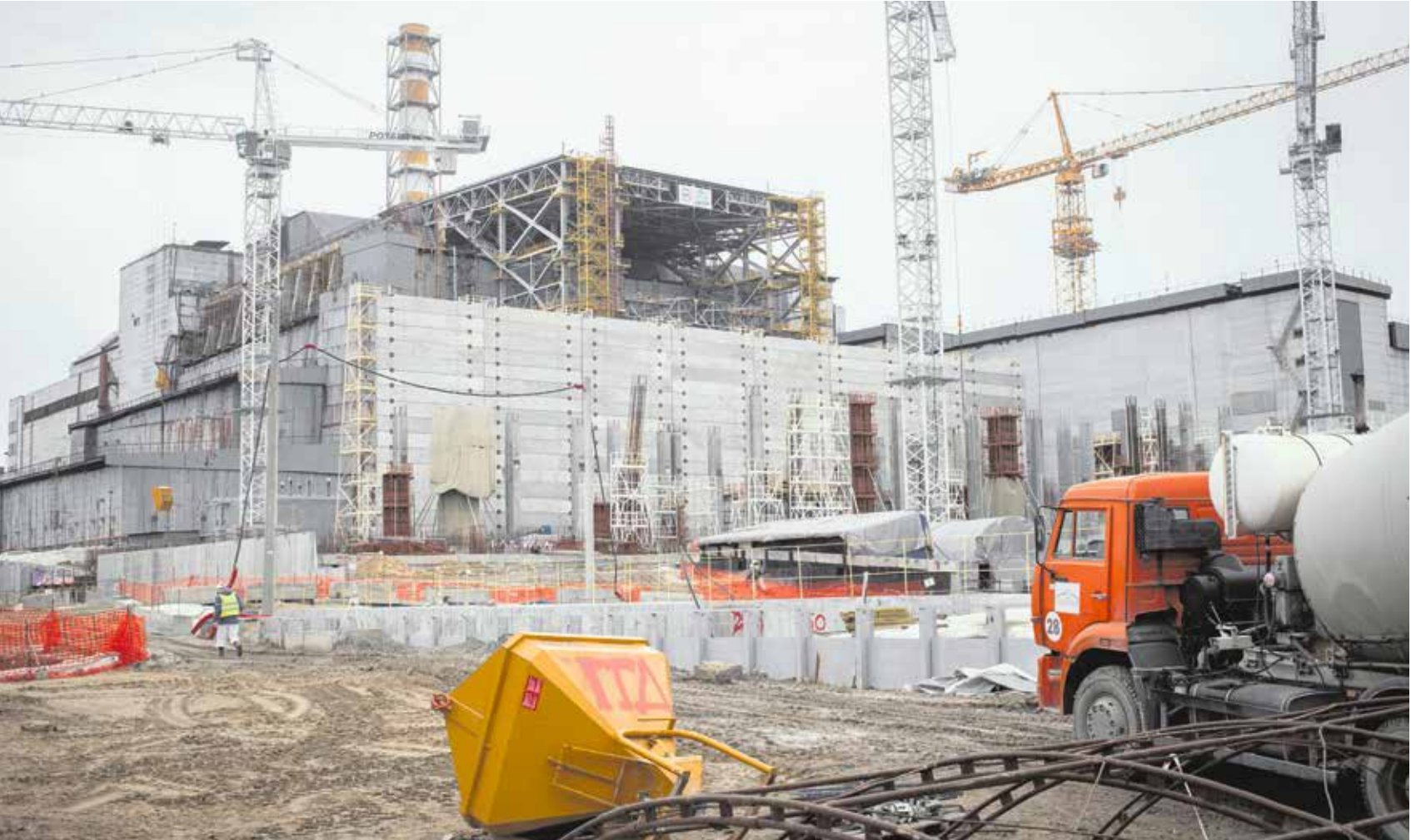
Der Sarkophag verschwindet in einer «neuen Arche»: Arbeiten am zerstörten Atomkraftwerk.
