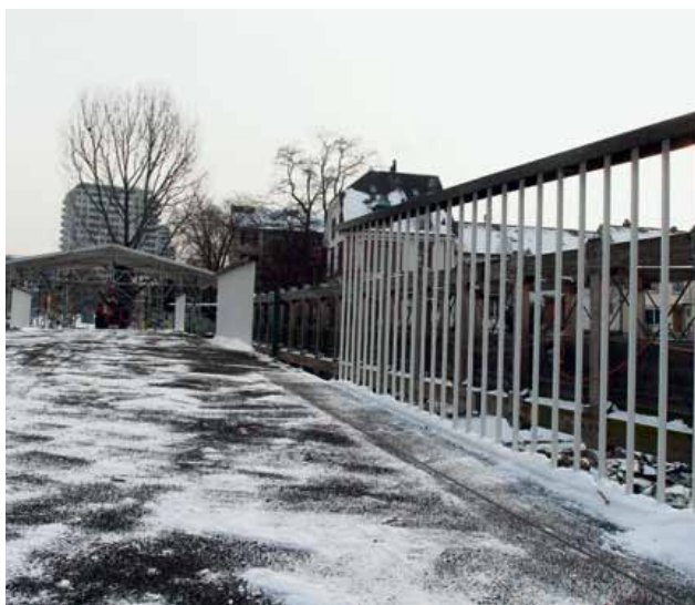
Die dünnste Balkenbrücke – leider passen die Geländer nicht. Foto: Michael Würtenberg
