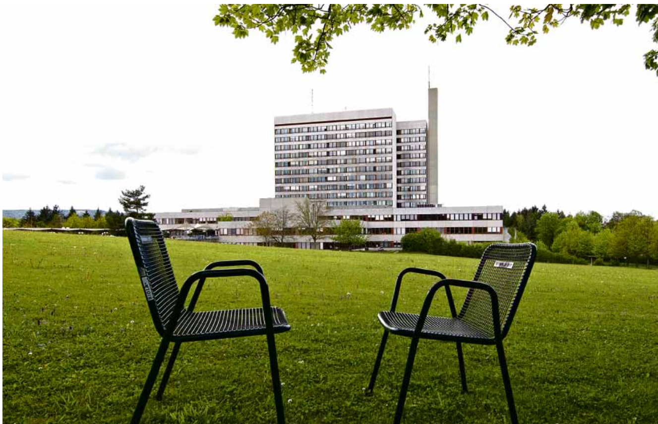
So sicher wie eine Bank? Oder doch eher so unsicher wie ein klappriger Stuhl? Die Standfestigkeit des Bruderholzspitals wird sehr unterschiedlich beurteilt. Foto: Hans-Jörg Walter
