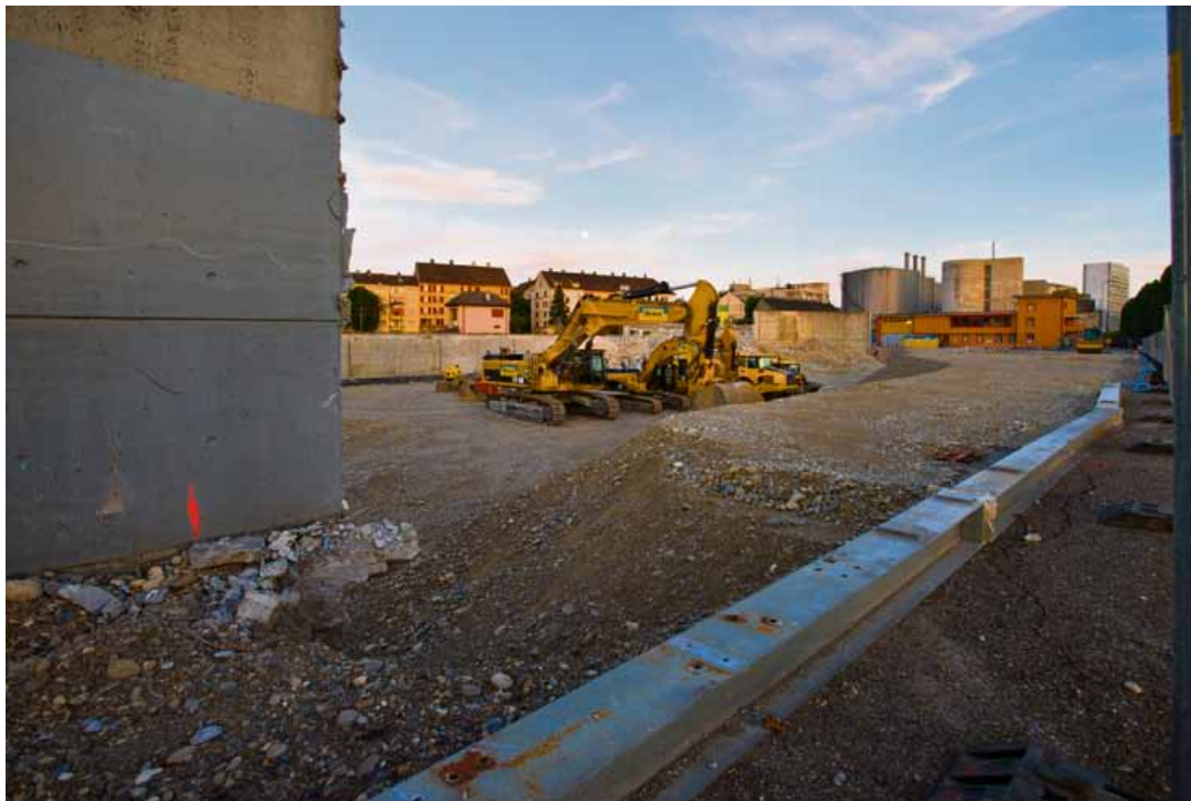
Das ehemalige Migrol-Areal wird derzeit rückgebaut. Die GLP will dort bereits ab 2013 Wohnungen sehen. Foto: Alexander Preobrajenski
