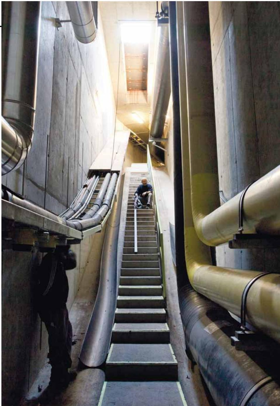
Nahes des Novartis Campus kann der Erdboden geöffnet werden, um Rohre im Untergrund zu warten und zu installieren.
