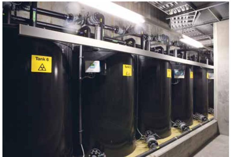
Bis zu 70 Tage wird radioaktives Abwasser der Krebspatienten in unterirdischen Tanks gelagert, bevor es zur Kläranlage geleitet wird.
