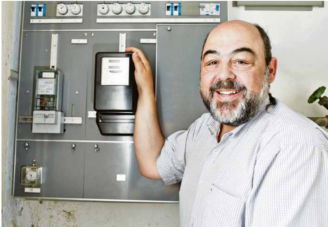
Philip Karger liess den neuen Stromzähler wieder ausbauen, der ihn zum gläsernen Kunden machen könnte. Foto: Hans-Jörg Walter
