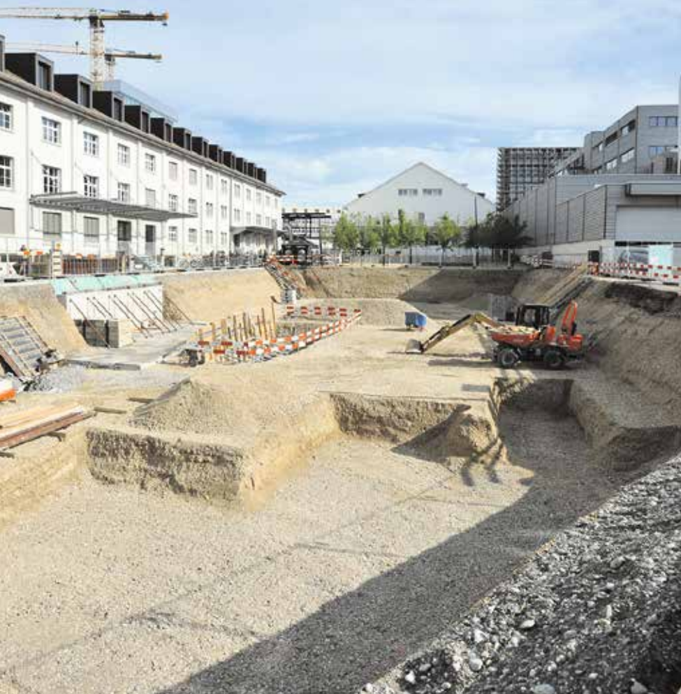
Die Baugrube, auf der das vierstöckige Gebäude stehen wird. FOTO: A. PREOBRAJENSKI
