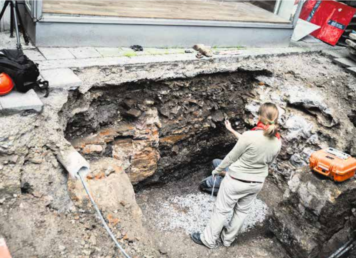
Die Bauarbeiten am Rümelinsplatz haben die Reste einer alten Mühle freigelegt.
