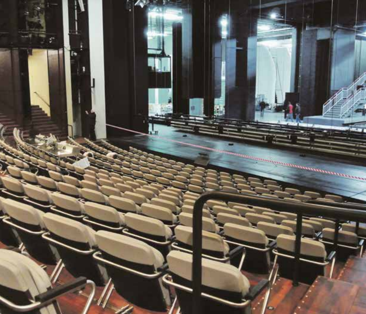
Während ein Streit ums Geld tobt, ruhen die Arbeiten.
