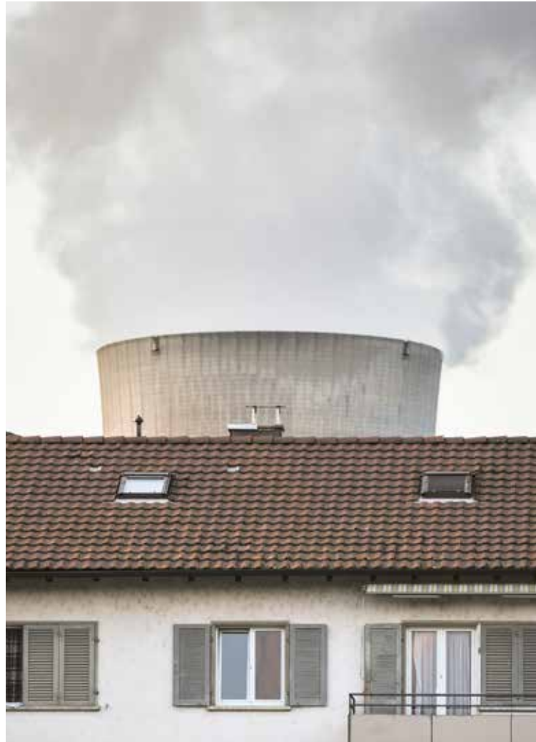
Der Kühlturm kann weg, ohne dass anderswo CO 2 aufsteigt.
