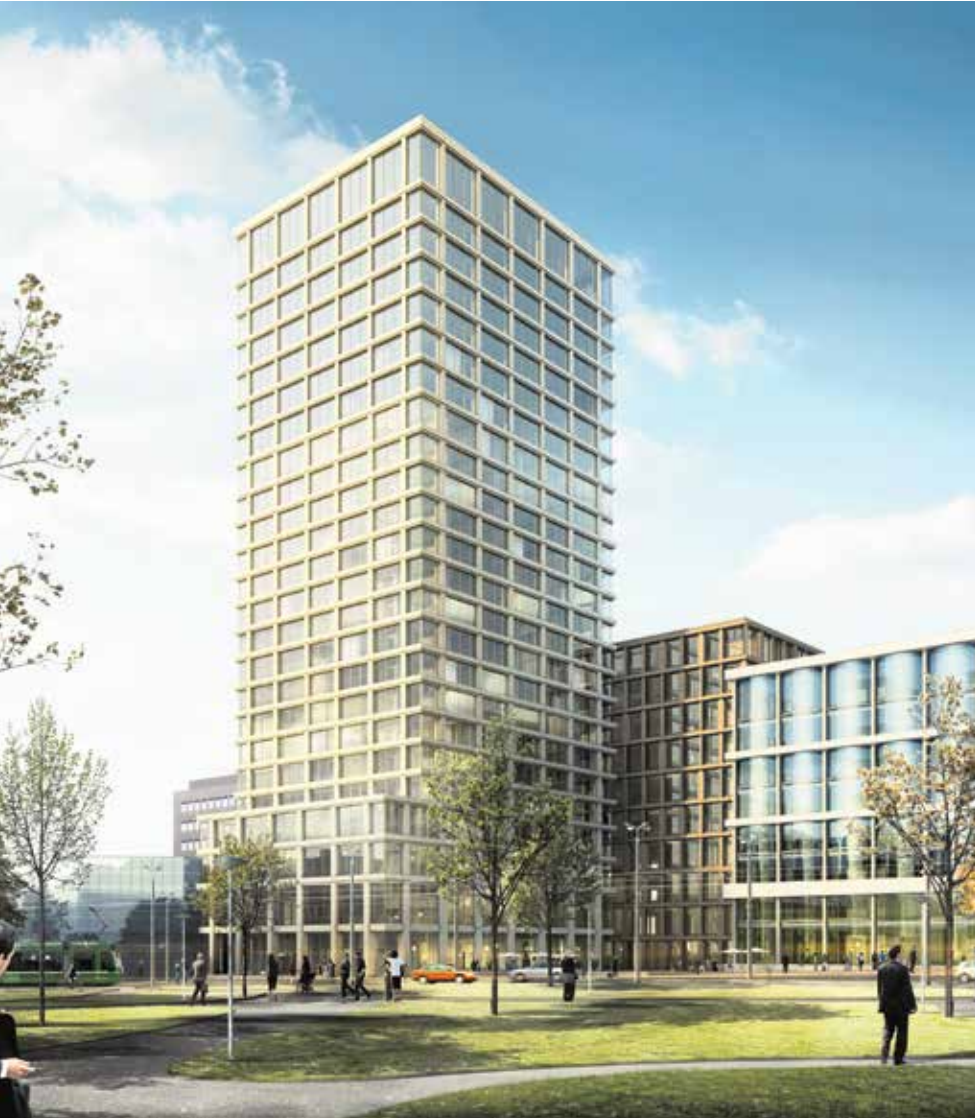
Gesamtansicht des neuen Bauensembles mit Büros und Hotel. VISUALISIERUNG: BALOISE
