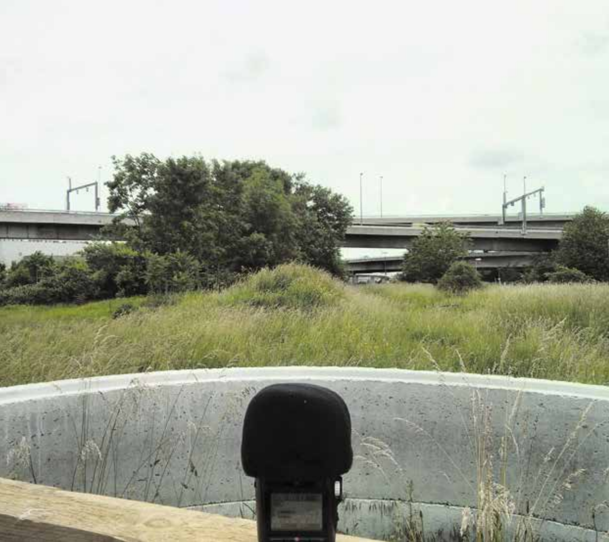
Zu laut: 700 Meter Lärmschutzwände sollen hier für Ruhe sorgen. FOTO: PATRIK TSCHUDIN
