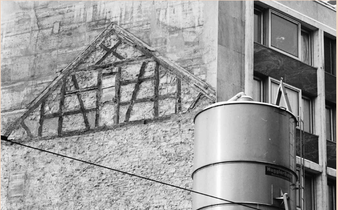
Spuren eines Dachstocks an der Seitenwand des früheren «Drachen» in der Aeschenvorstadt.
