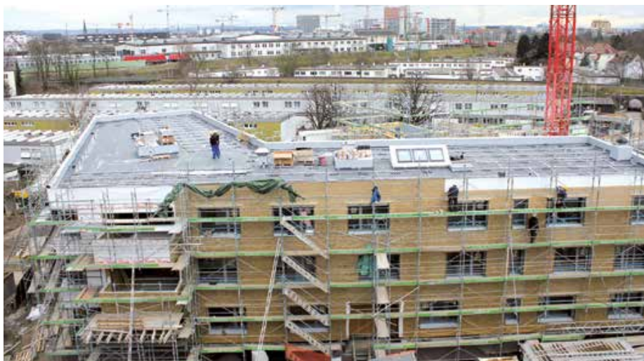
Die „schorenstadt“ im März 2014. Montage der Holzschindeln.
