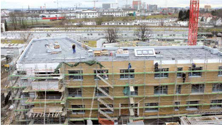
Die „schorenstadt“ im März 2014. Montage der Holzschindeln.
