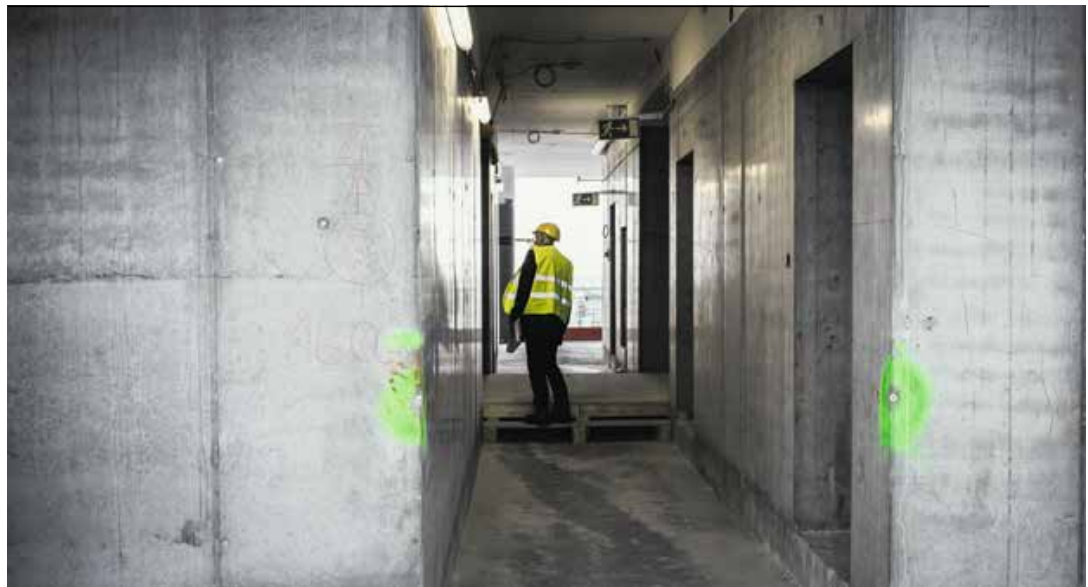
Im 500 Millionen teuren «Bau 1» der Roche sollen einmal 2000 Menschen arbeiten.
