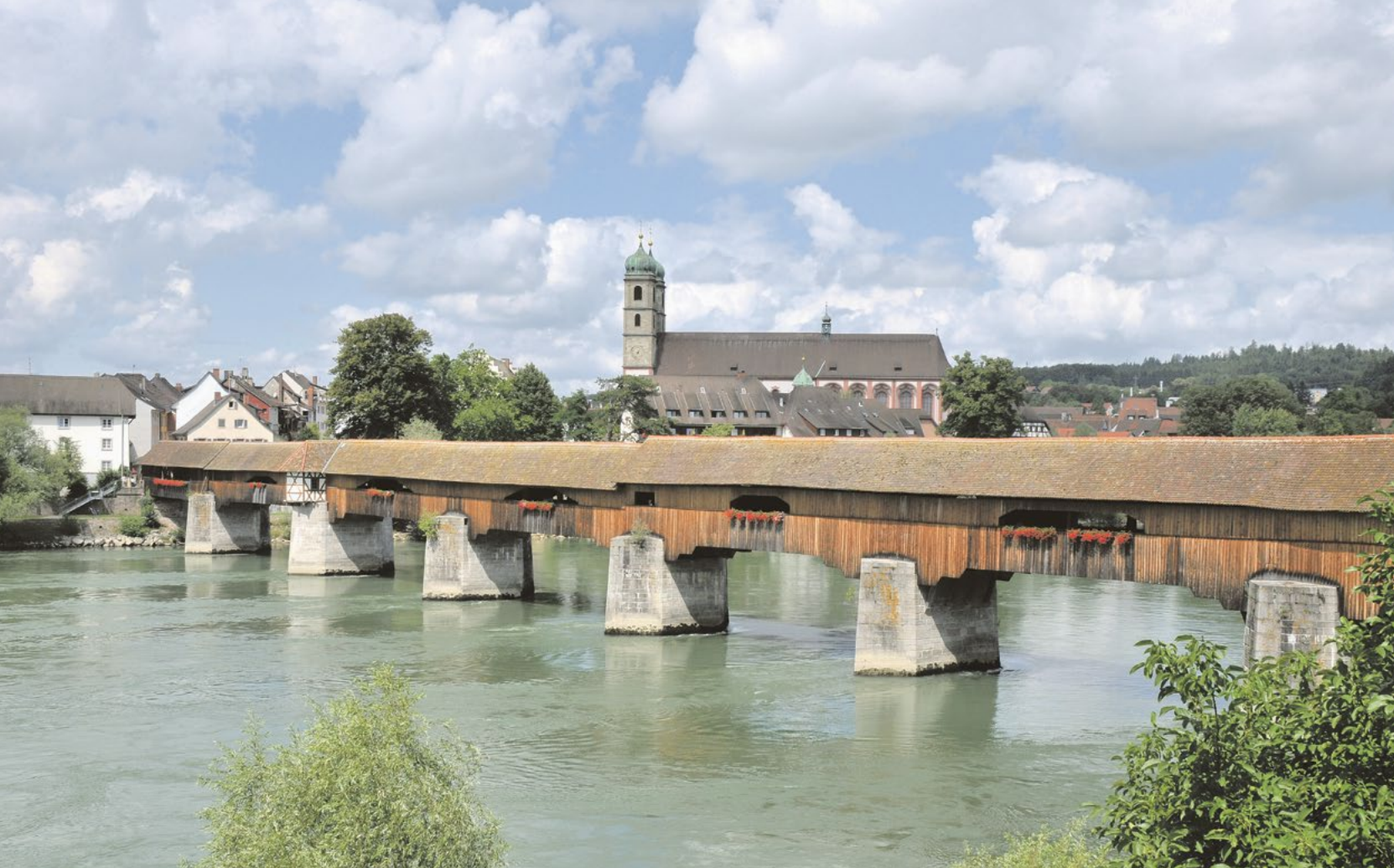
Verbindung in die EU: Rheinbrücke zwischen Bad Säckingen (D) und Stein (CH).
